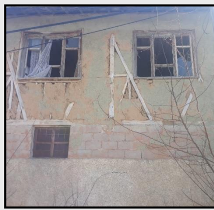
Foto 10: Harabe Konuttun Duvar Yapımı
