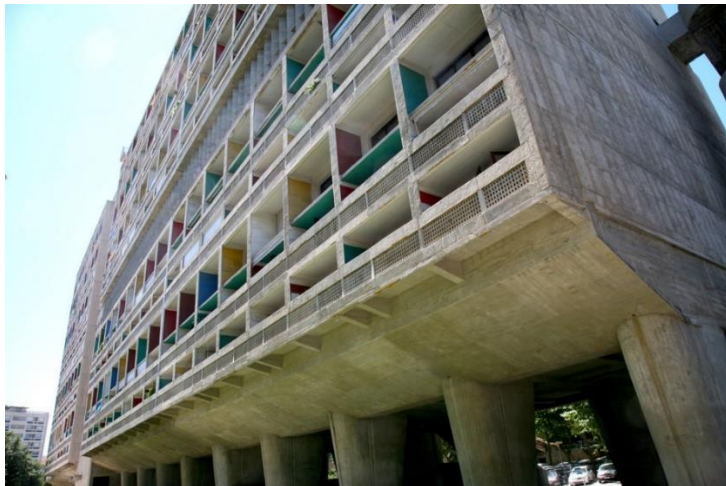
Şekil 1: Unite d’habitation (Barınma Ünitesi), - Le Corbusier, - Marsilya, Fransa Yapım yılı: 1952
